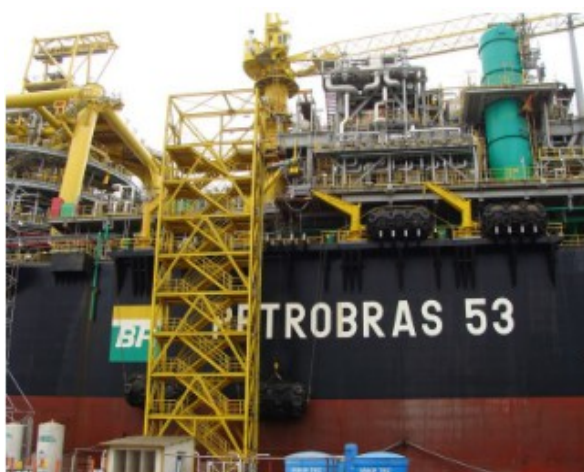
Construção de plataforma no estaleiro
